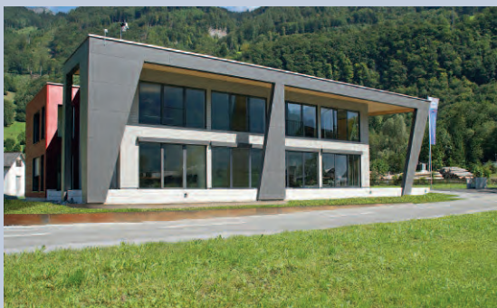
Neuer Gebäudetyp «Gebäude mit geringen Abmessungen», welcher weitestgehend ohne Brandschutzmassnahmen erstellt werden kann
