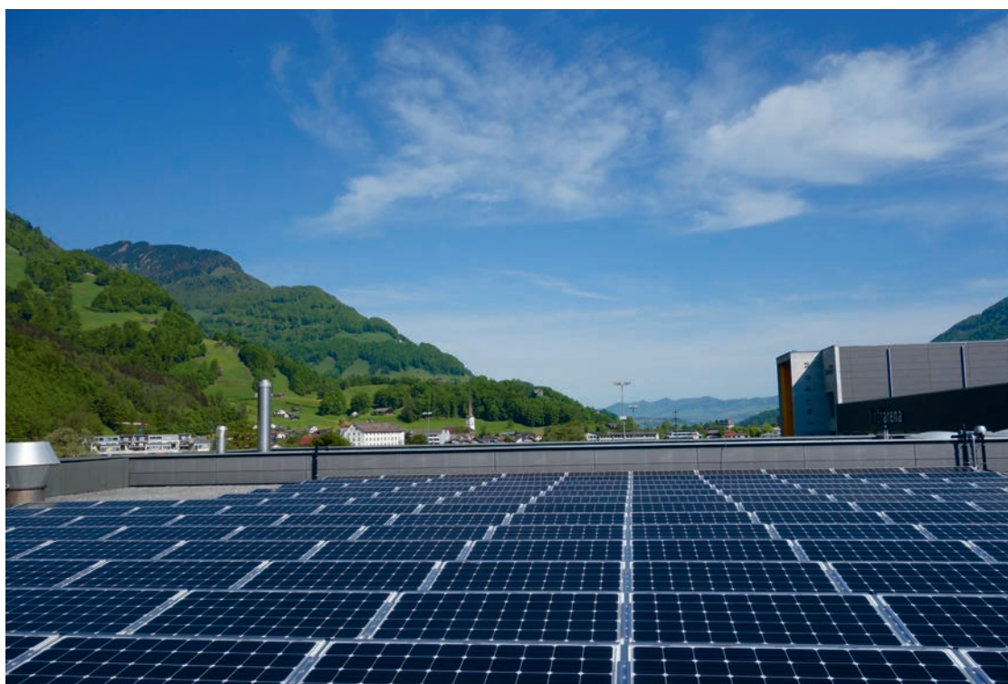
Solaranlage der glarnerSach auf dem Dach der lintharena sgu
