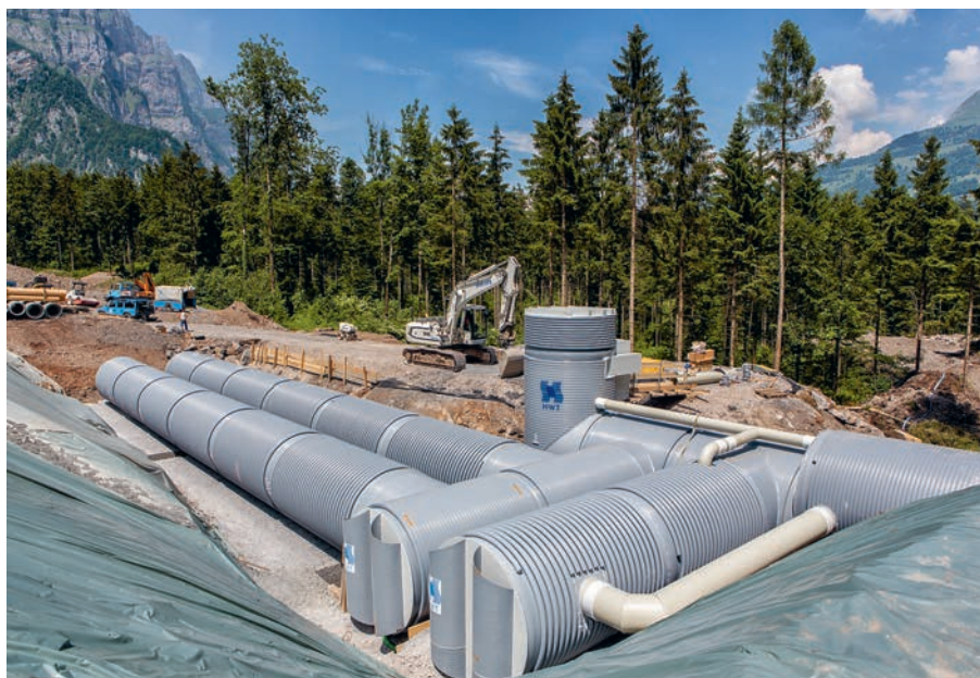
Sanierung Wasseranlagen Brunnenstübli
