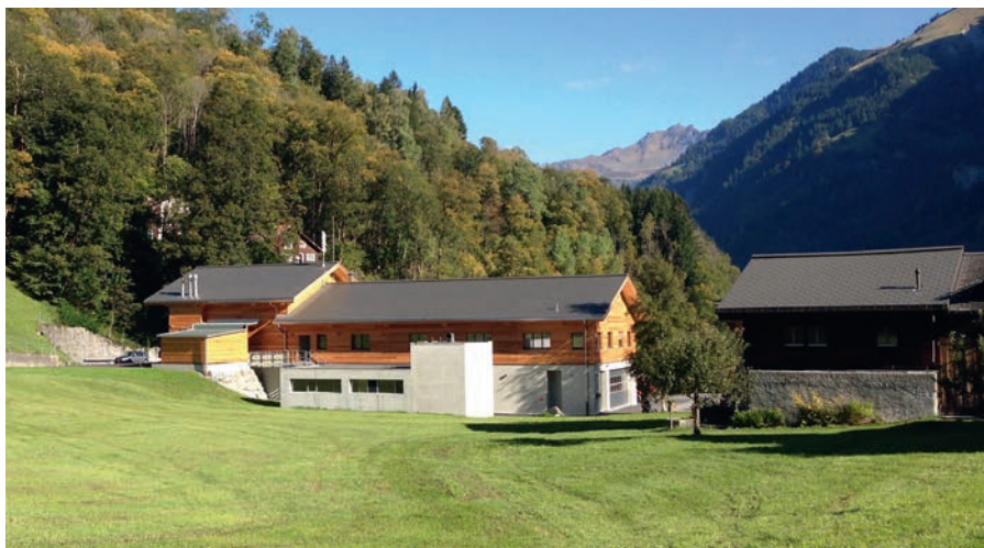
Neubau Forst- und Feuerwehrgebäude Elm
