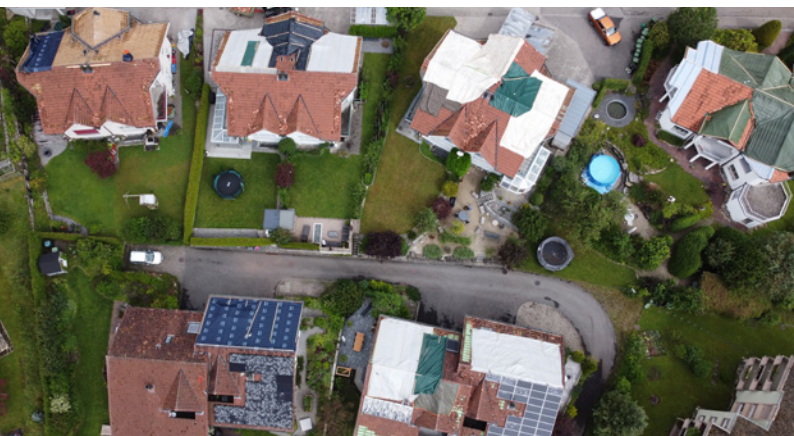
Hagelschlag im Kanton Luzern beschädigte die Dächer ganzer Dörfer
