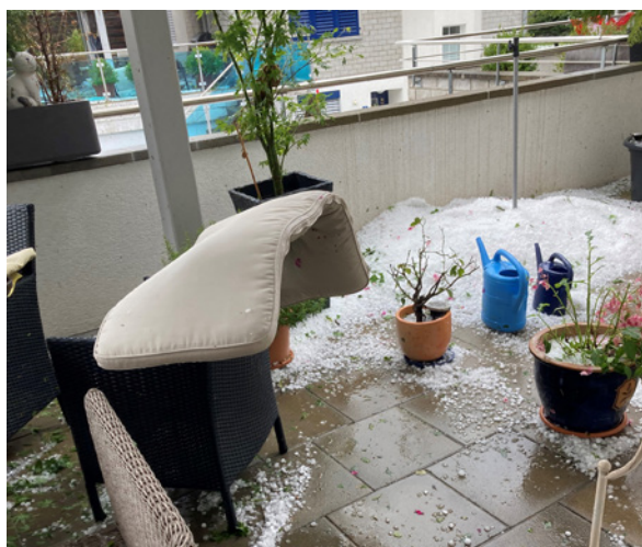
Unwetter mit Hagel verursachten grosse Schäden an Fahrhabe und Gebäuden
