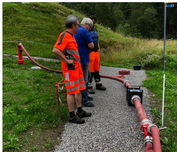
Abnahme neuer Hydrantenleitungen im Krauch, Glarus Süd
