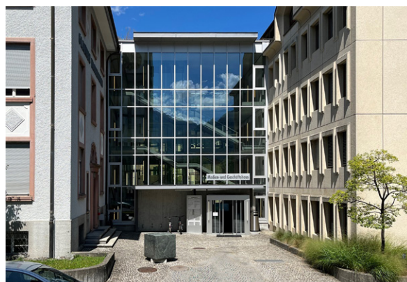
Mit einer Gesamtsanierung wird das Geschäftshaus in die Zukunft geführt
