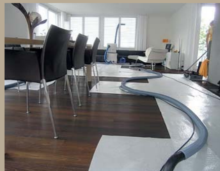
Die umfassenden Installationen für die Trocknung eines Unterlagsbodens, verunmöglichen ein «ordentliches Wohnen» während längerer Zeit.
