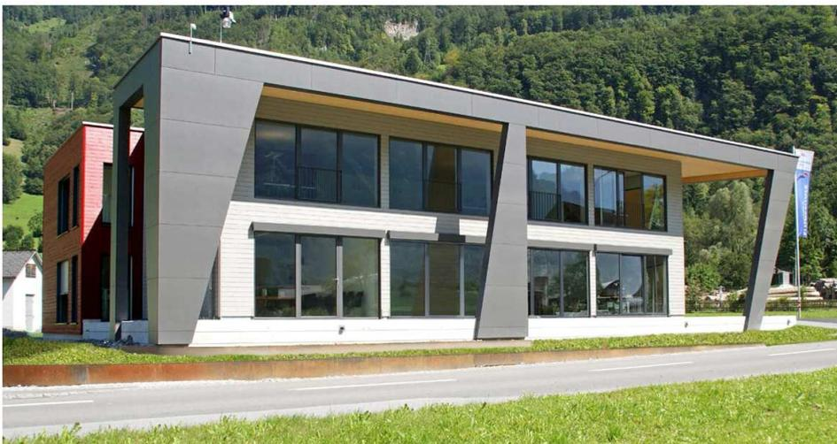
*Neuer Gebäudetyp «Gebäude mit geringen Abmessungen», welcher weitestgehend ohne Brandschutzmassnahmen erstellt werden kann.*
